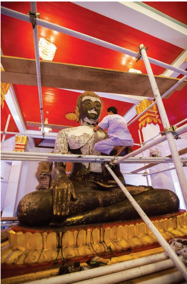
คณะช่างทำการจัดปัวแต่งผิวพระองค์แสนเพื่อเตรียมผิวทำแบบพิมพ์ยางซิลิโคน ภาพ : สำนักงานโยธาธิการและผังเมืองจังหวัดสกลนคร
