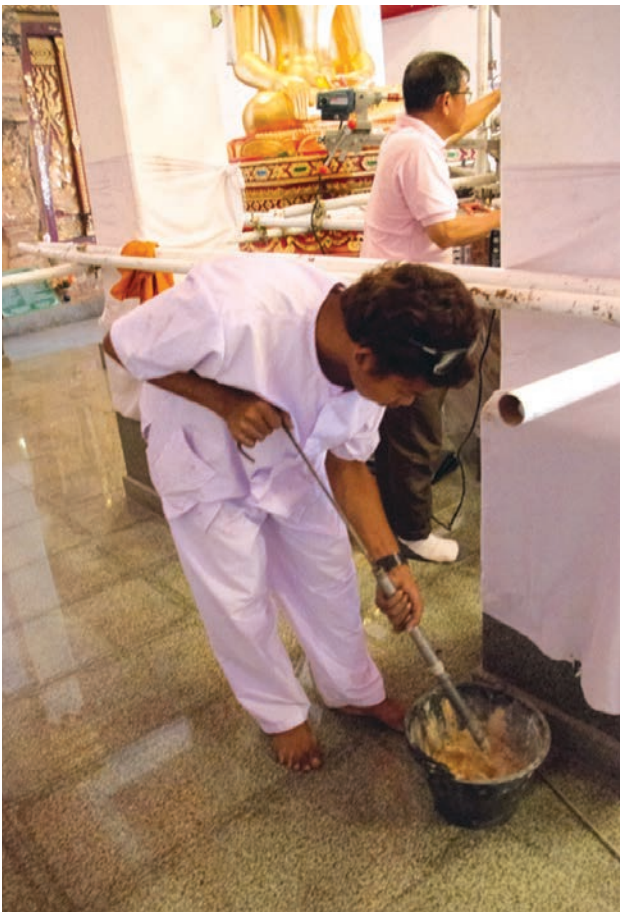
เมื่อเจาะได้ระยะจะต้องถอดก้นเจาะเพื่อนำผงอิฐของพระองค์แสนที่อุดตันก้นเจาะออก ภาพ : สำนักงานโยธาธิการและผังเมืองจังหวัดสกลนคร
