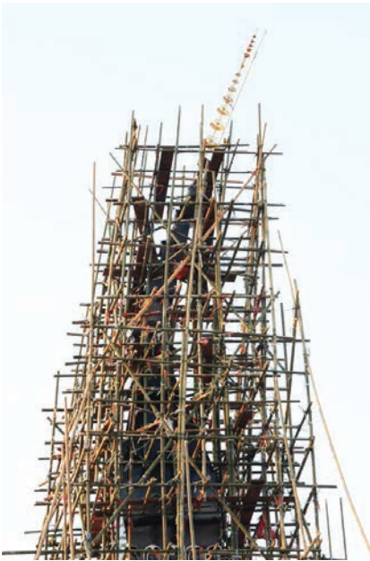
พายุพัดปลืยอด พร้อมวัดรองคพระธาตุเชิงชุม หักค้ำงอยู่บนนั้งร้าน ขณะอยู่ใน ระหว่างดำเนินการลงรักปิดทอง กลุ่มเรือนยอด ถ่ายเมื่อวันที่ ๒๐ มีนาคม พุทธศักราช ๒๕๕๗ ภาพ : สำนักงานเจ้าคณะจังหวัด สกลนคร วัดพระธาตุเชิงชุม วรวิหาร อำเภอเมืองสกลนคร จังหวัดสกลนคร
