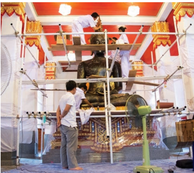
วิศวกรโยธาผู้ควบคุมงานดูแลการติดตั้งนั่งร้านและลอกผิวทองพระองค์แสน ภาพ : สำนักงานโยธาธิการและผังเมืองจังหวัดสกลนคร
