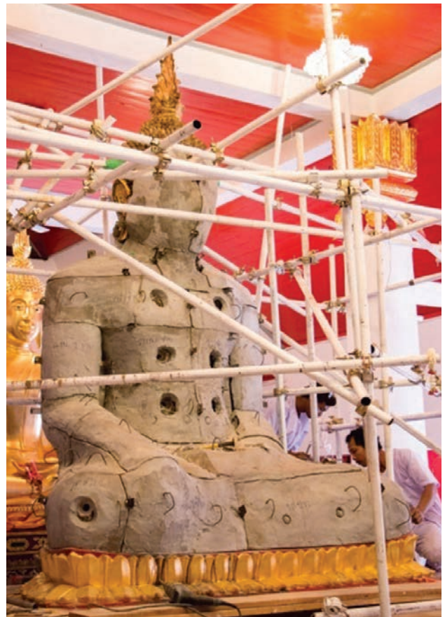
คณะช่างได้ทำการหล่อประกอบเปลือกเข้ากับพระองค์แสนและติดตั้งนั่งร้านค้ำยันอย่างมั่นคง สำหรับทำการเจาะรูขนาด ๑ นิ้วจำนวน ๑๑ จุดตามตำแหน่งที่กำหนด ในแบบการบูรณะของกรมศิลปากร
