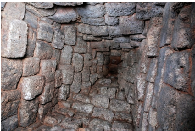
โครงสร้างภายในองค์พระธาตุเชิงชุม มีวัสดุโครงสร้างหลักเป็นศิลาแลง เสากรอบประตูเป็นหินทราย ภาพ : สถาบันภาษา ศิลปะและวัฒนธรรม มหาวิทยาลัยราชภัฏสกลนคร
