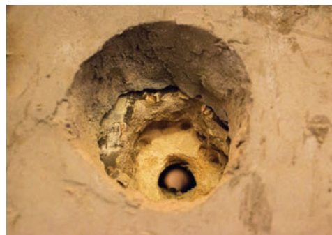
บริเวณรูเจาะ พบผิวเดิมขององค์พระ ปรากฏขึ้นปูนใหม่จากการบูรณะครั้งก่อนปิดทับอยู่ ภาพ : สำนักงานโยธาธิการและผังเมืองจังหวัดสกลนคร
