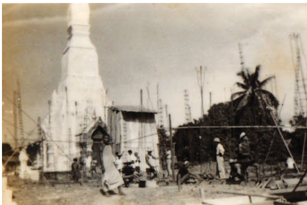
ดำเนินการก่อสร้างพระวิหารหลังใหม่ สัญญาจ้าง งวดที่ ๑ กิตติวันออกเฉียงใต้ ถ่ายเมื่อพุทธศักราช ๒๔๔๘
