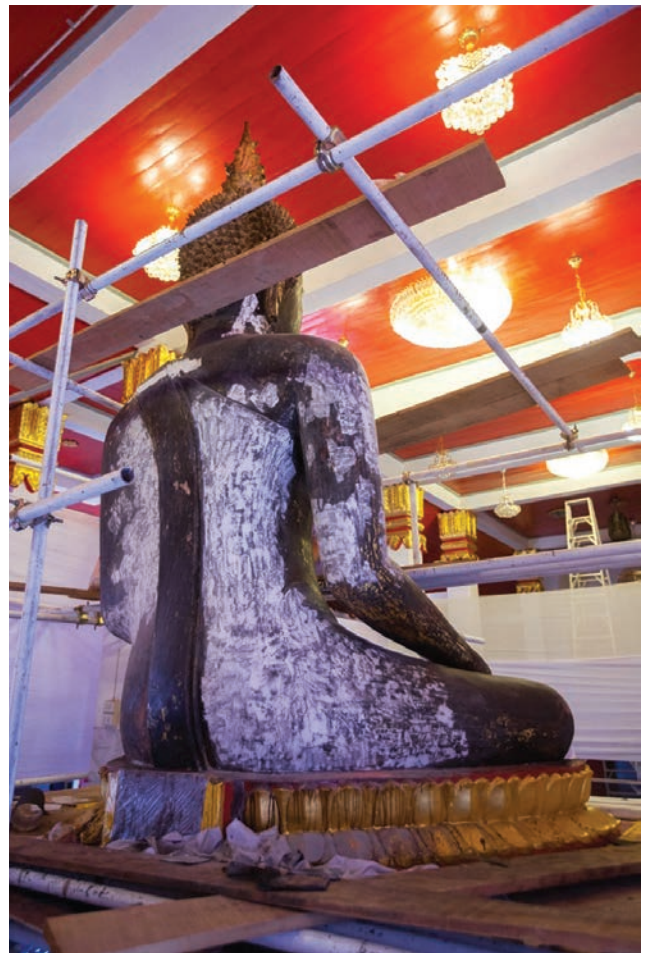
คณะช่างทำการจัดปัวแต่งผิวพระองค์แสนเพื่อเตรียมผิวทำแบบพิมพ์ยางซิลิโคน ภาพ : สำนักงานโยธาธิการและผังเมืองจังหวัดสกลนคร
