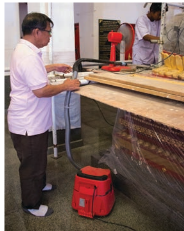
ทุกระยะของการเจาะ ช่างใช้เครื่องดูดเศษผงอิฐที่อยู่ในรูเจาะออกมา และเก็บผงอิฐน้ำส่งให้วัด ภาพ : สำนักงานโยธาธิการและผังเมืองจังหวัดสกลนคร
