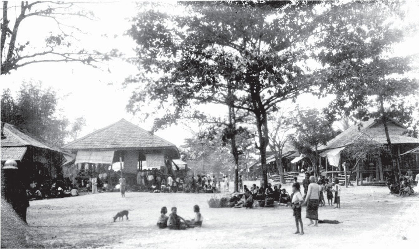
ภาพ : ศาลาที่ทำการรัฐบาลประจำจังหวัดสกลนคร หรือศาลากลาง จังหวัดสกลนครหลังแรกที่ทางราชการจัดสร้างขึ้น เมื่อปีพุทธศักราช ๒๔๓๕ เพื่อใช้เป็นที่ทำการแห่งใหม่ โดยแยกออกมาจากที่พักเจ้าเมืองเดิม ปัจจุบันคือ พื้นที่บริเวณถนนเจริญเมือง ตัดกับถนนใจอาสา ถ่ายเมื่อประมาณปีพุทธศักราช ๒๔๗๕ - ๒๔๘๐ ที่มา : คุณธงชัย ลิขิตพรสวรรค์
