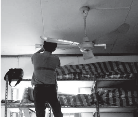
ซ่อมบำรุงระบบไฟฟ้า
